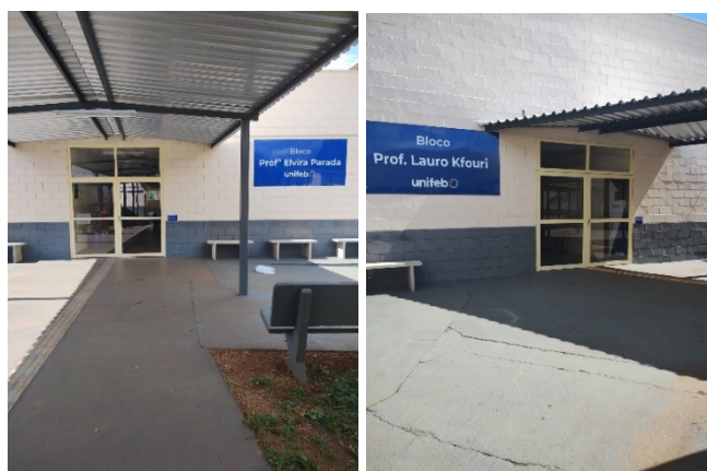
Figura 4.3 – Instalação de portas nas entradas dos blocos de salas de aula Fonte: Unifeb
